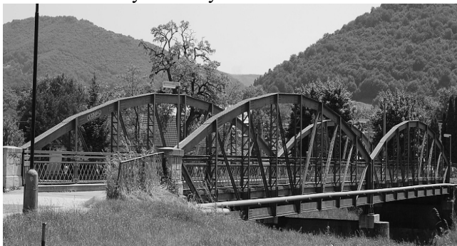
Železný most cez Laborec postavený v roku 1900
